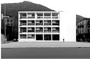
Como, Casa del Fascio
