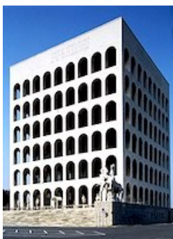
Roma EUR , Palazzo della Civiltà del Lavoro .
