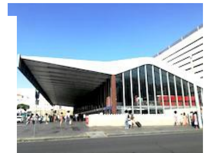
Roma , Stazione Termini, ala laterale .
