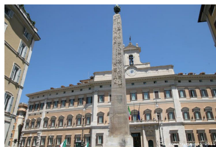
Roma – Palazzo di Montecitorio
